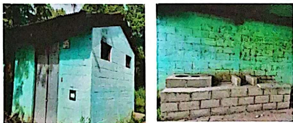
REPARACION DE AREA DE COCINA
