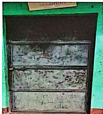
MANTENIMIENTO DE 9 PUERTAS
