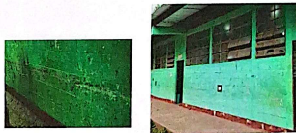
Foto 2: PINTURA EN INTERIOR Y EXTERIOR EXTERIOR DE LOS MODULOS, DIRECCION Y AULAS
